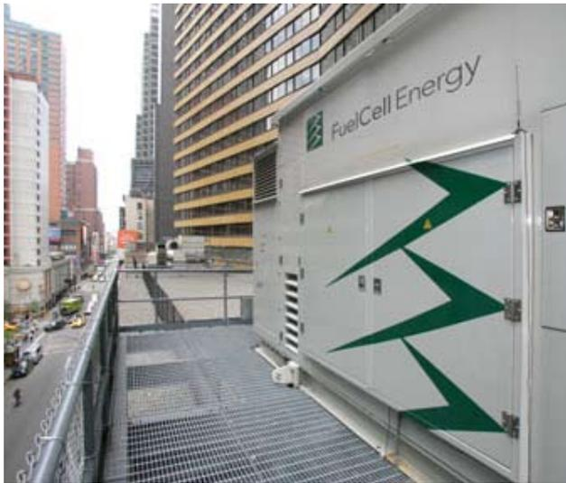
Топливный элемент мощностью 250 кВт, входящий в состав системы, обеспечивающей электроэнергоснабжение и горячее водоснабжение гостиницы «Шератон» в Нью-Йорке.
